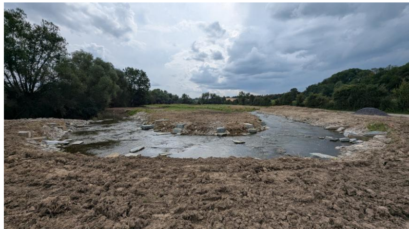
07.08.24 Sohlgleite bei MW
