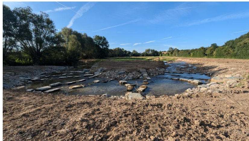
12.08.24 Sohlgleite bei NW
