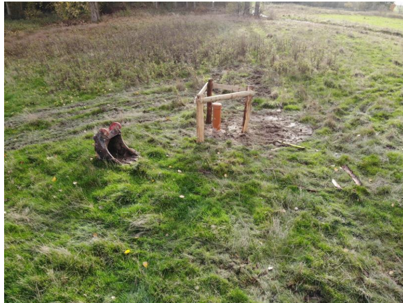
Anlage von eines Grundwassermessnetzes (Oktober 2022)
