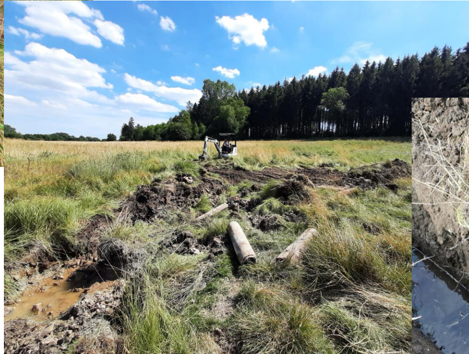
Offenlegung einer verrohrten Quelle
