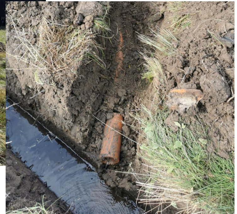
„Sauger“ Drainagerohr aus Ton
