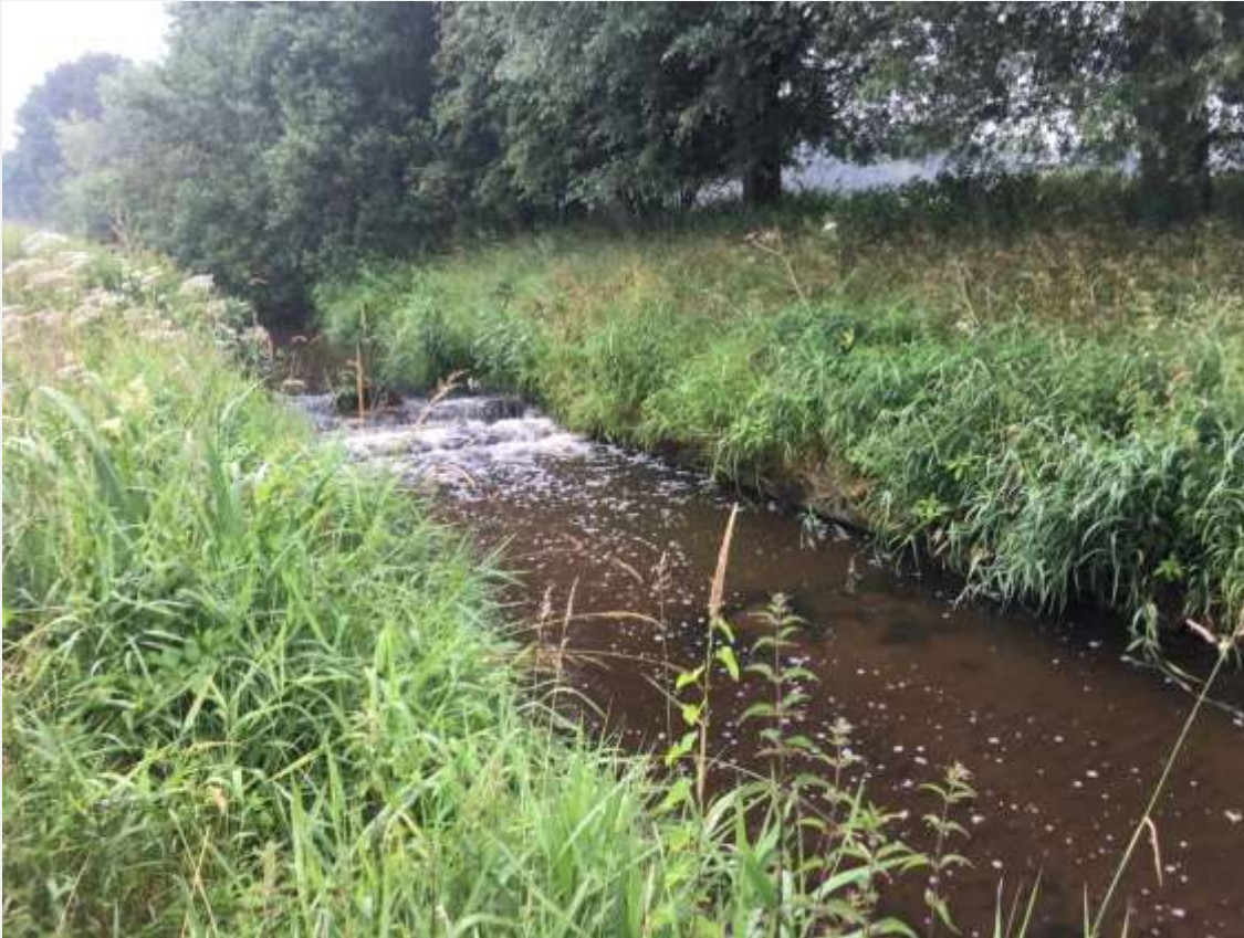
Ems westl. Kaunitzerstraße: vor Maßnahmenumsetzung
