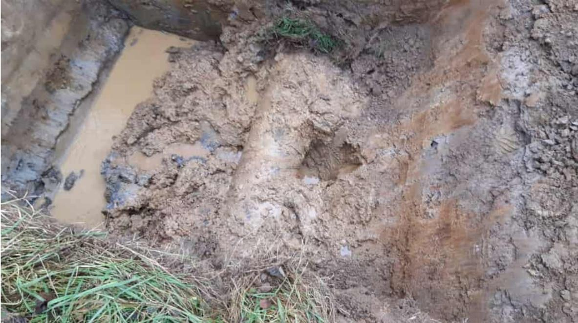
Sämtliche Ver- und Entsorgungsleitungen wirken als Drainage. Insbesondere die Kies-/Sandbettung von Rohren wirkt drainierend. Durch den Einbau von Lehmdichtungen wurde im Projektgebiet an vier Stellen die Entwässerungswirkung der vorhanden Schmutzwasserleitung unterbrochen.
