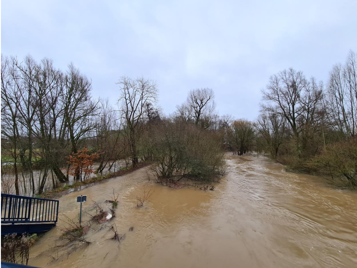
100 m oberhalb Mündung Lippe (links) und Alme (rechts), Foto gewässeraufwärts von der Fußgängerbrücke aus aufgenommen. [Foto vom 24.12.23]
