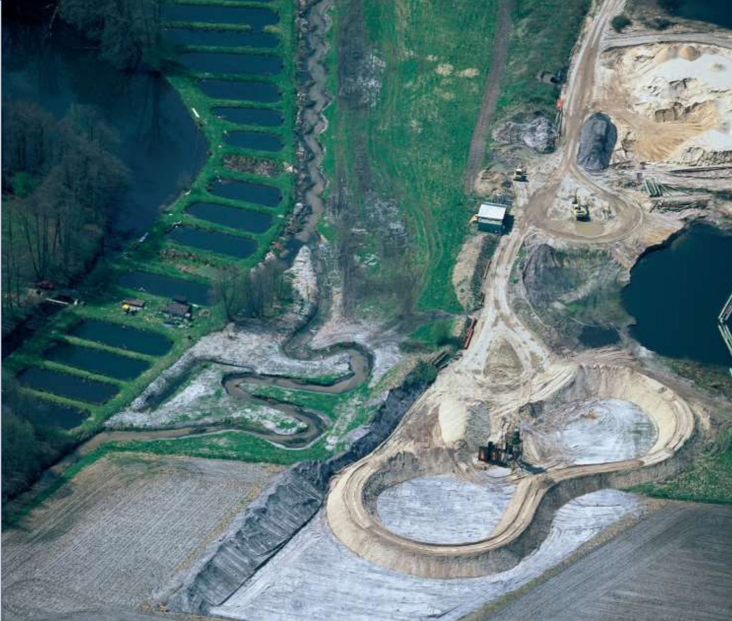
Anlage eines naturnahen Gerinnes und einer Sohlgleite am Furlbach im Bereich einer Fischteichanlage
