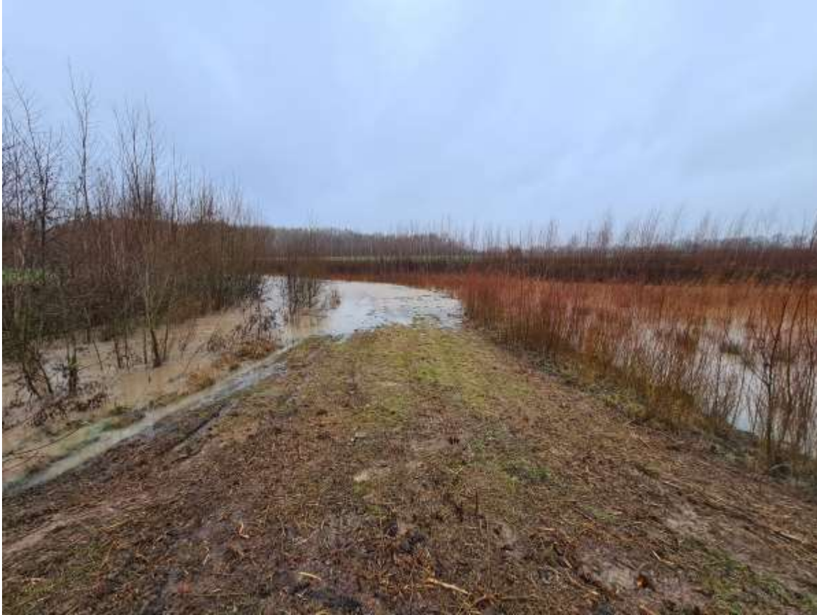
Trotsbach Horn, Blick von der Brücke auf die Überlaufschwelle in die Hochwassermulde (Foto vom 23.12.23)
