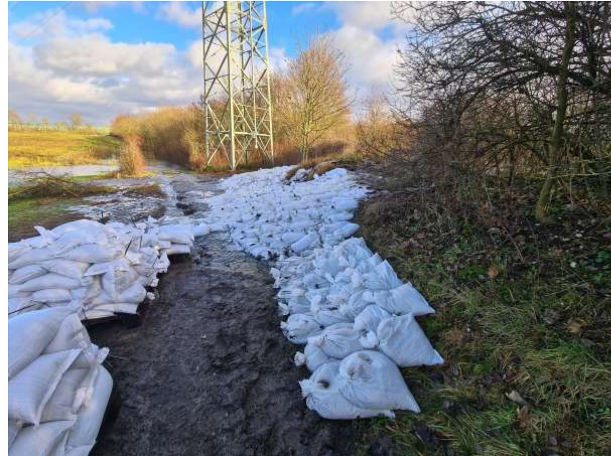
Ehem. Abgrabung östlich Kreuzweg: aus der in Hochlage verlaufenden Steinbeke strömt geplant und schadlos Wasser über die von der Feuerwehr zur Sicherung der Verwallung aufgebrauchten Sandsäcke. Durch das hier abströmende Hochwasser kam es in der Ortslage Bad Lippspringe nicht zu einem weiteren Anstieg des Wasserstands. (Foto vom 26.12.23)
