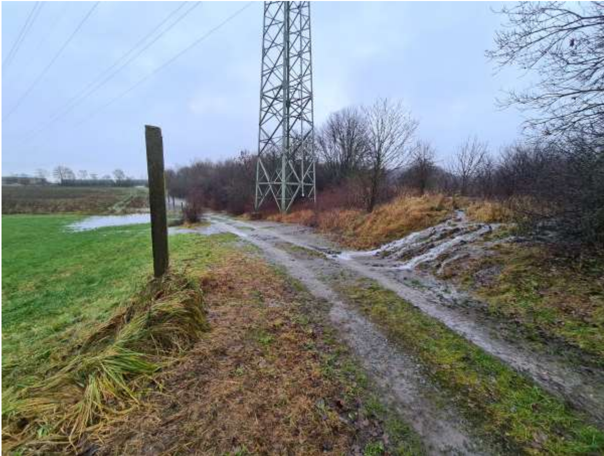
Ehem. Abgrabung östlich Kreuzweg: aus der in Hochlage verlaufenden Steinbeke strömt Wasser über die Verwallung (Foto vom 25.12.23)
