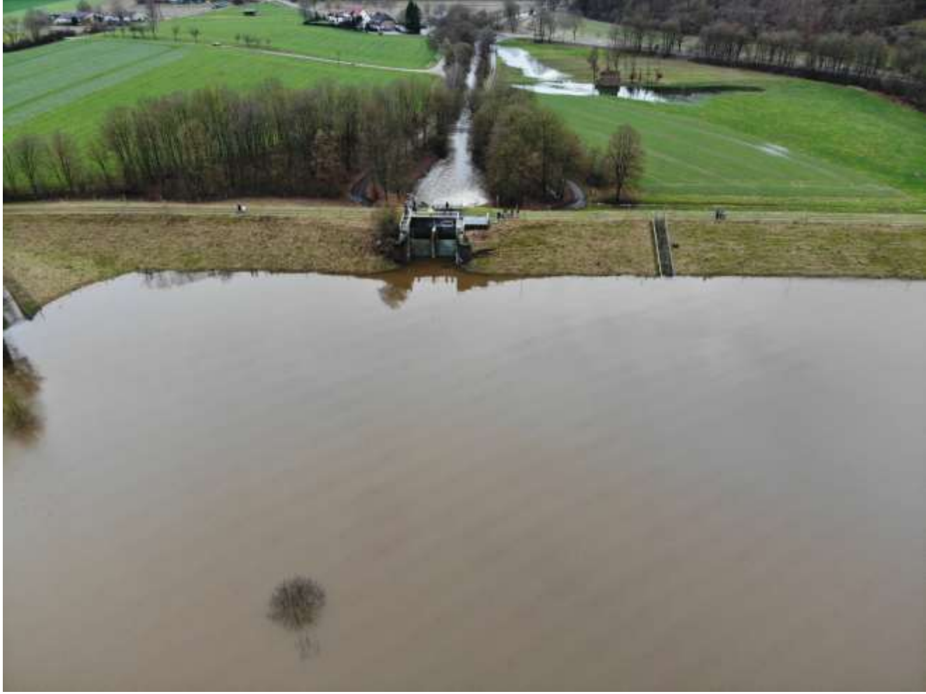
HRB Ebbinghausen Blick auf die Hochwasserentlastung
