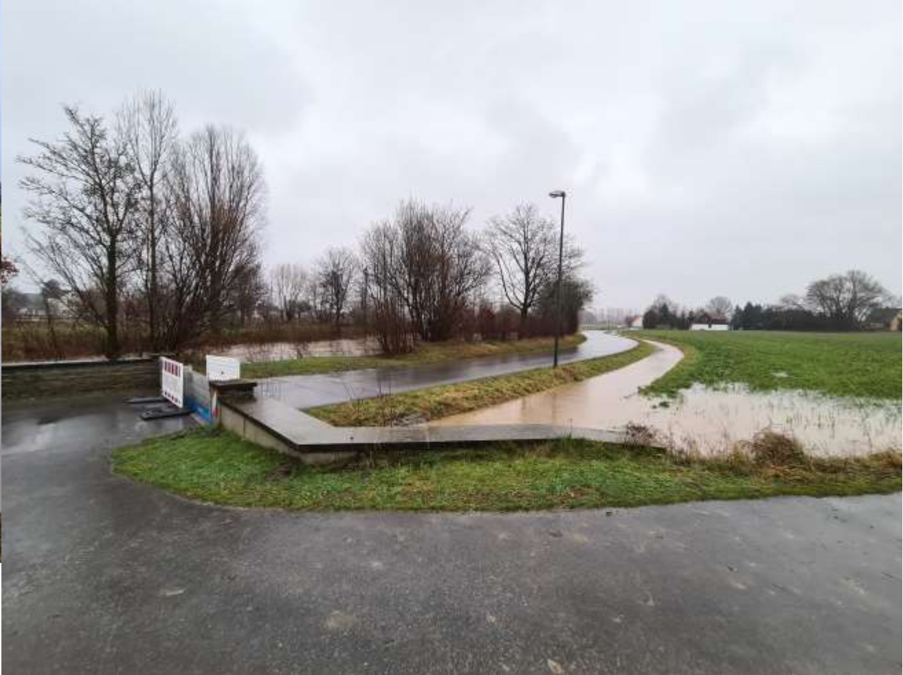
Gieseler – Overhagen: Dammbalken am Glaseweg, 23.12.23
