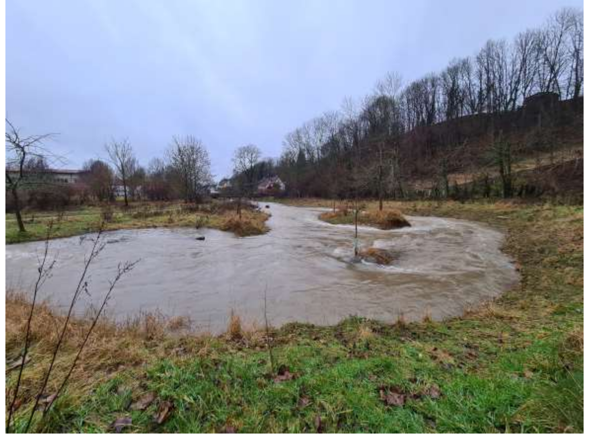
Beke Neuenbeken, Blick auf den Renaturierungsabschnitt An der Bischofsmühle (Foto vom 25.12.23)
