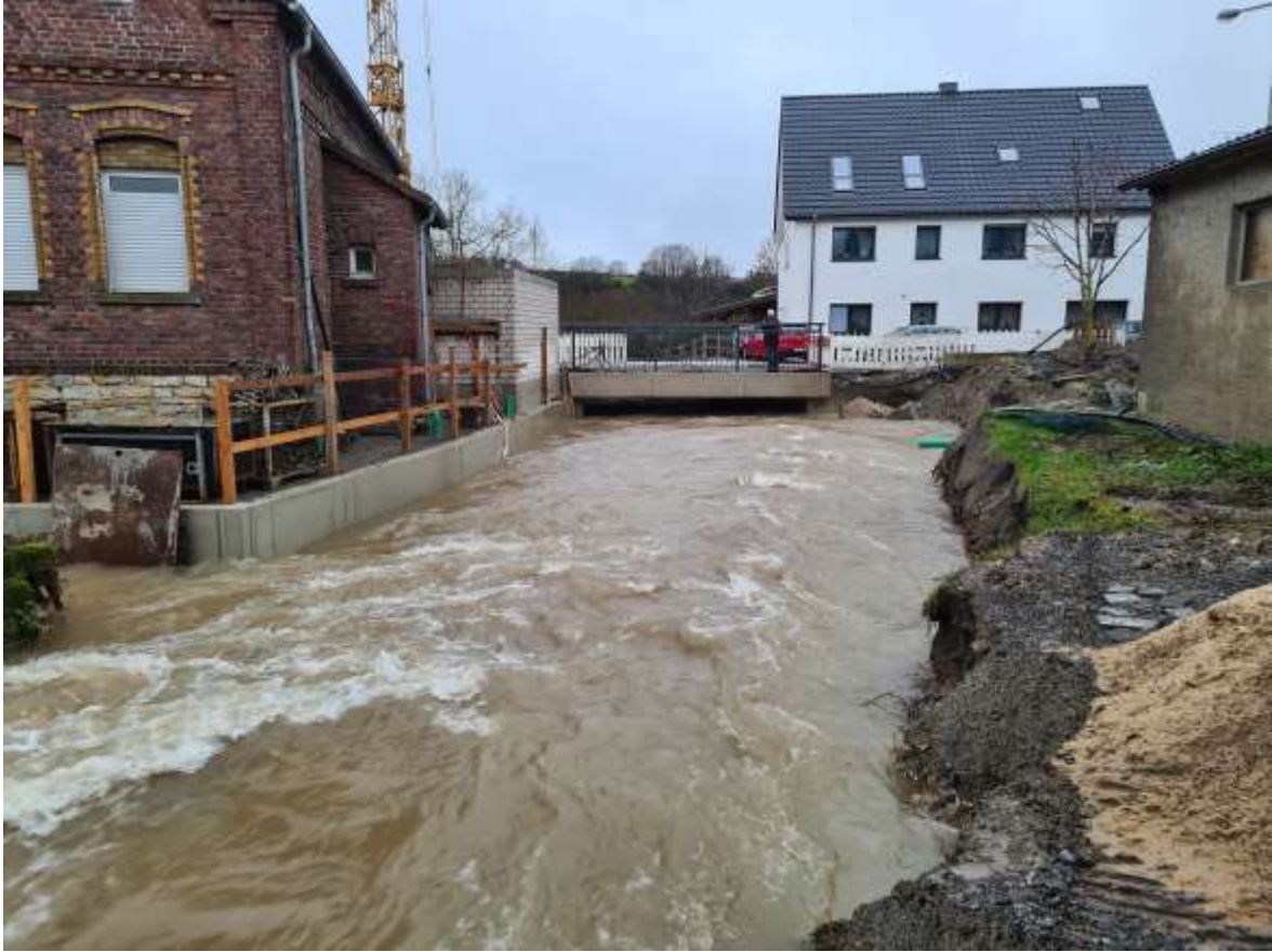
Beke Neuenbeken, Blick auf die Brücke Gogrevenstraße (Foto vom 25.12.23)
