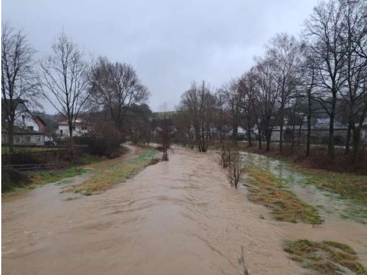
Brücke Kirchstraße, Blick in Fließrichtung (Foto vom 23.12.23)
