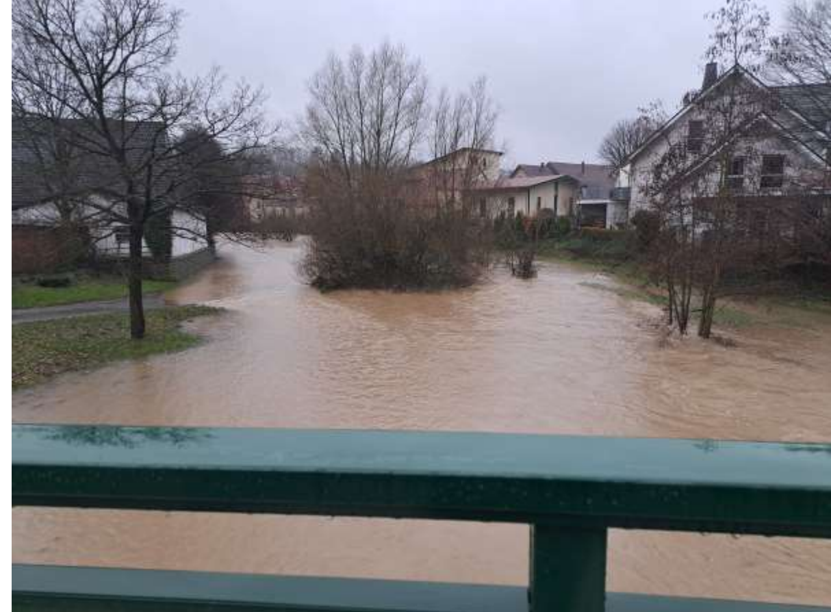
Brücke Kirchstraße, Blick gegen Fließrichtung (Foto vom 23.12.23)
