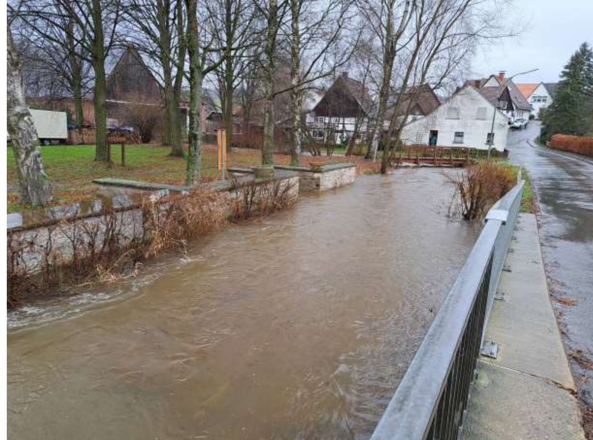
Höhe Paderborner Str. 8, Blick in Fließrichtung (Foto vom 29.12.23)
