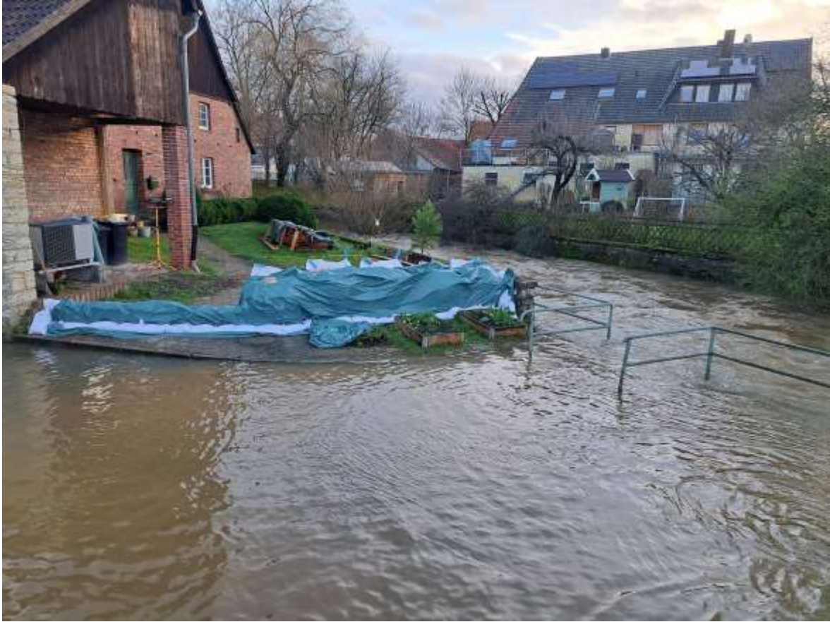
Höhe Hellweg 9, Blick gegen Fließrichtung (Foto vom 26.12.23)
