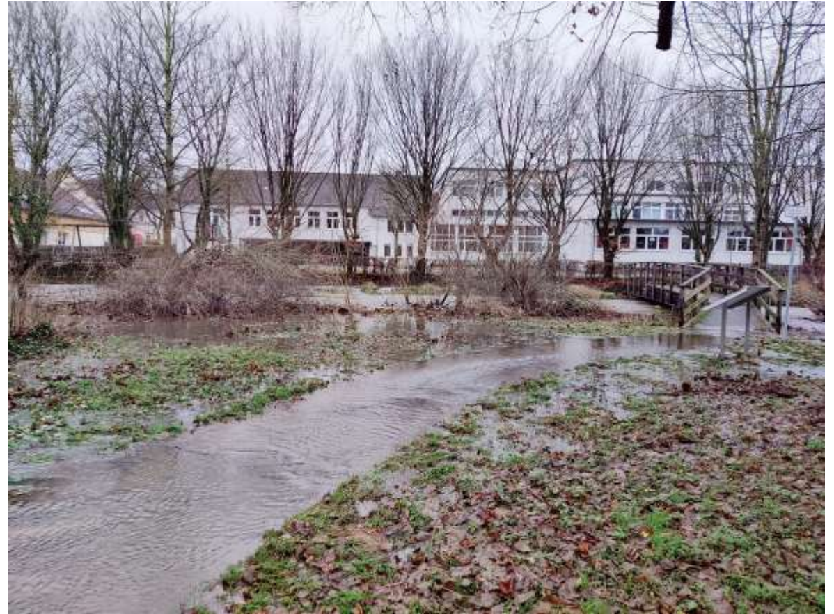
Fußgängerbrücke Adam&Eva, Blick zur Alme (Foto vom 23.12.23)
