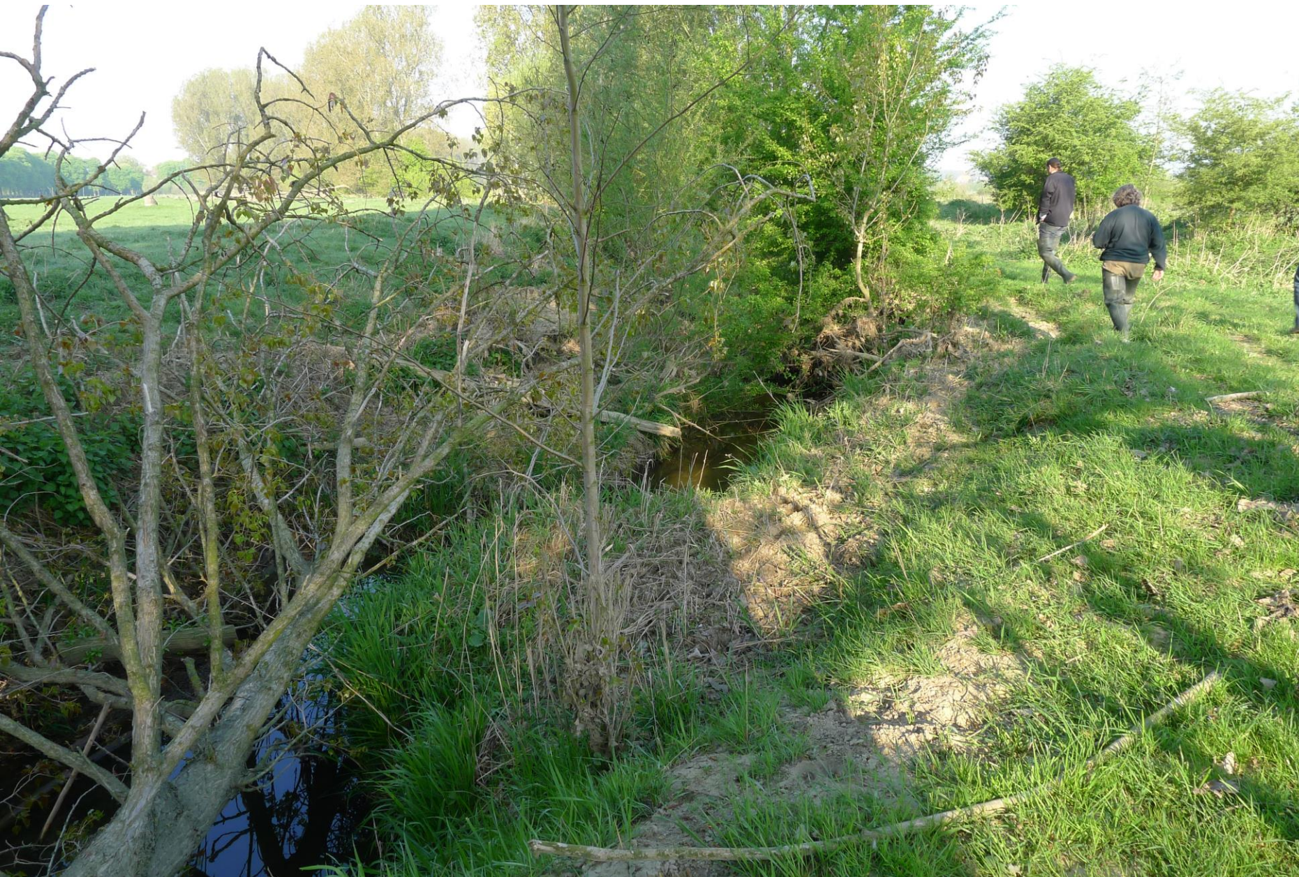
20. April 2011 Vorherzustand Trotzbach abgekoppelt von der Aue
