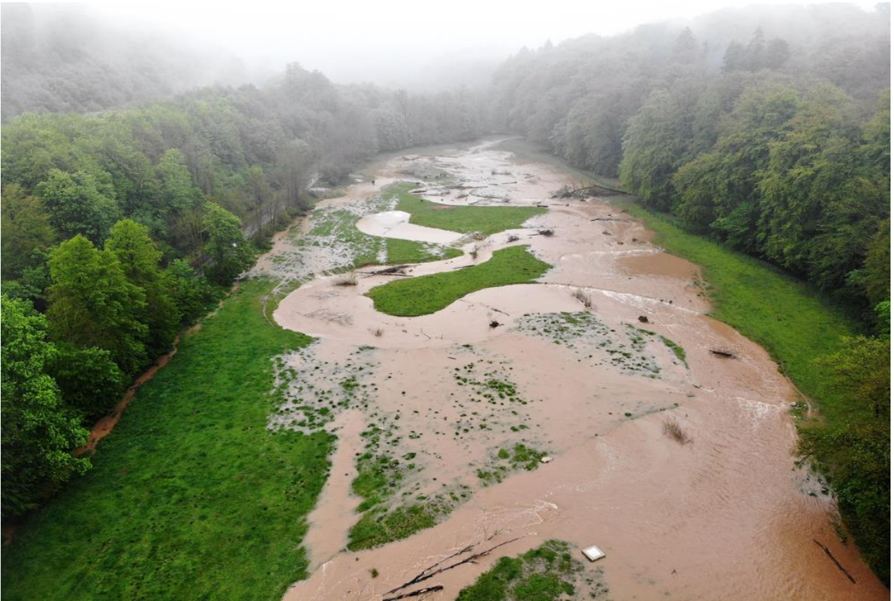
Altenau, Renaturierungsabschnitt im Stauraum des HRB Husen-Dalheim
