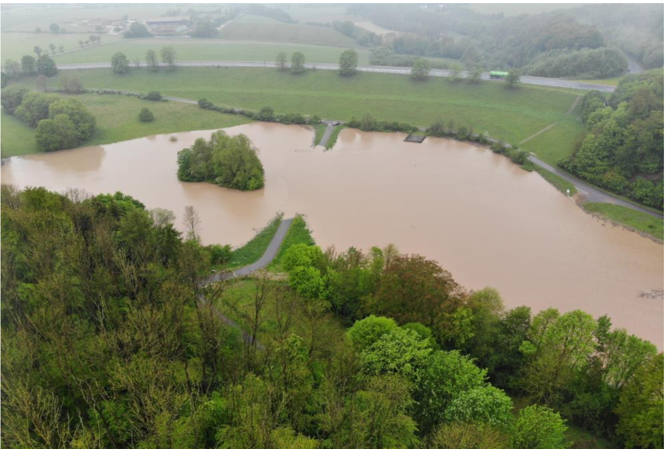
HRB Husen Dalheim mit überströmtem Trenndamm
