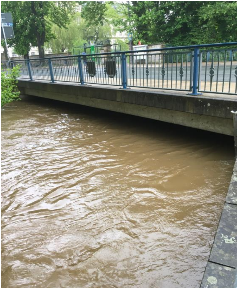
Almebrücke Bahnhofstrasse Büren, unterstromig
