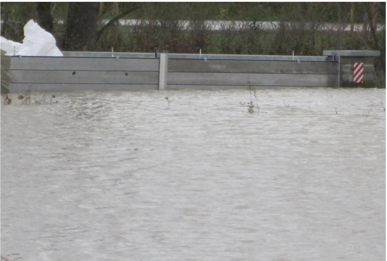
Gieseler, Dammbalkenverschluss in Overhagen
