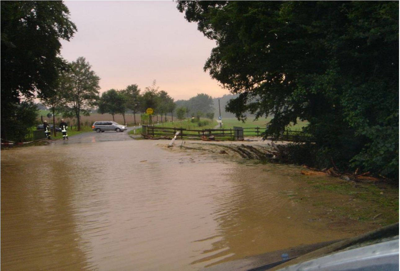
Alme in Ahden Bereich Nähe Autobahnbrücke
