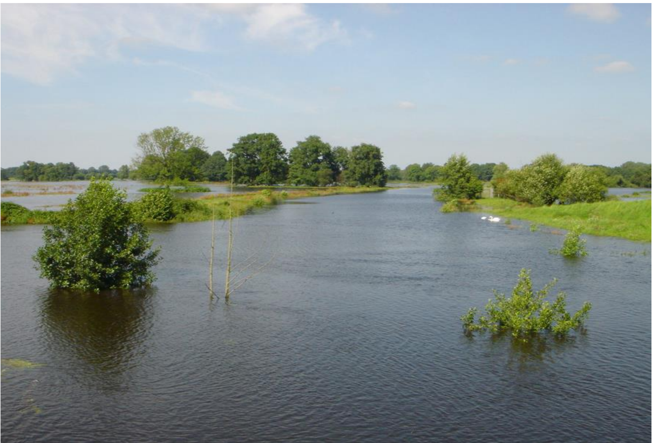
HRB Steinhorst Blick in den Stauraum
