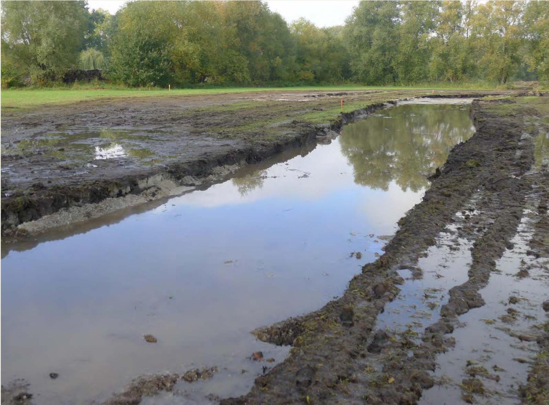
2. Baubeginn aufgrund der Bodenverhältnisse und Brut- und Setzzeit am 28.07.2014, zur Schonung des Bodens wurden fünf Kettendumper eingesetzt
