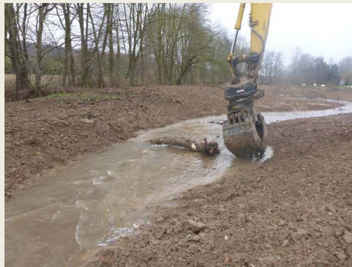
30.11.2015 Totholzeinbau zur Förderung der Strukturvielfalt
