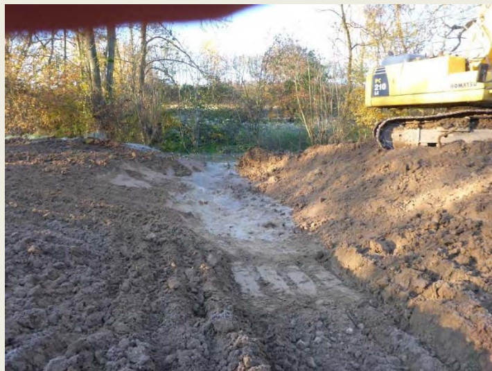
03.11.2015 Flutung des 1. Renaturierungsabschnittes
