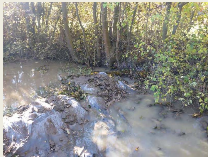
03.11.2015 Sediment- und Einschwimm Sperre unterhalb des Maßnahmegebietes
