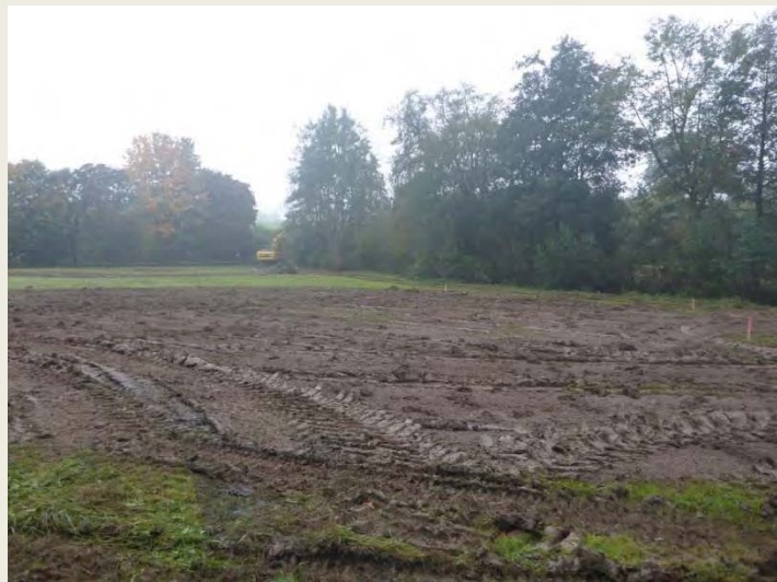
19.10.2015 Vorbereitung des Baufeldes
