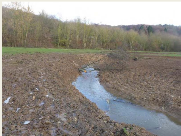
23.11.2015 Flutung des 2. Renaturierungsabschnittes
