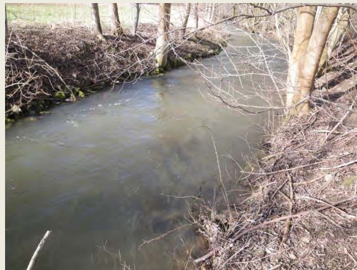
02.03.2010 Uferbefestigung aus Natursteinen und Bauschutt
