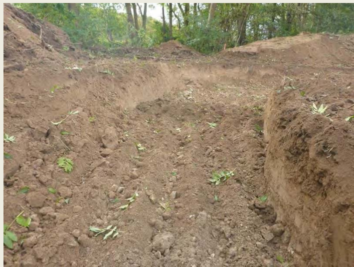
21.10.2015 Herstellung der neuen Gewässersohle auf anstehendem Kies
