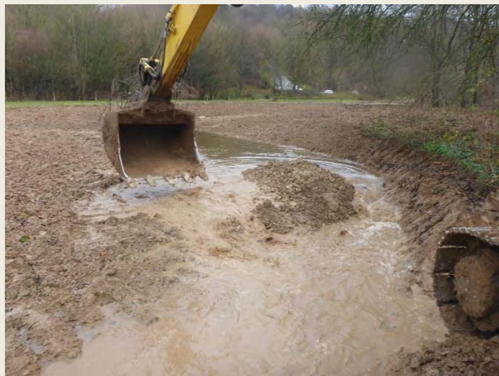
26.11.2015 Einbringen von örtlich gewonnenen Sohlsustrat
