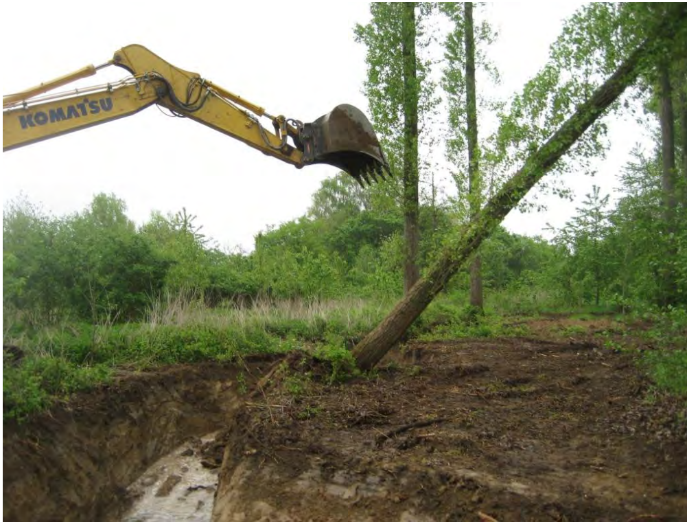
Abb. 3: Nach Fertigstellung des Gerinnes wurden am Ufer stehende Hybrid-Pappeln mit dem Bagger umgedrückt, um den Bachlauf strukturell anzureichern. Die Geometrie des Bachprofils ergab sich aus der Schaufelbreite des Kettenbaggers von 1,5 m (28. April 2014).
