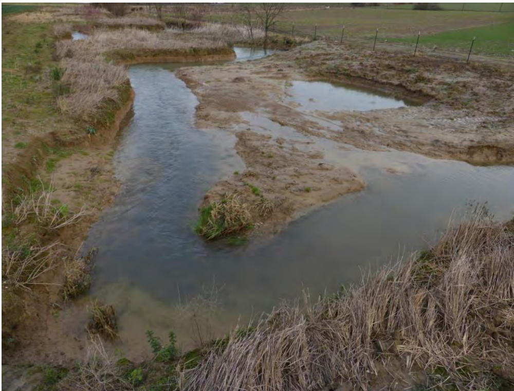
Abb. 25: In der Ersatzaue sind die Wasserstände kleinräumige differenziert. Über dem Kies strömt das Wasser schneller, eine wichtige Voraussetzung für die Eignung als Laichstrecke (18. Januar 2015).
