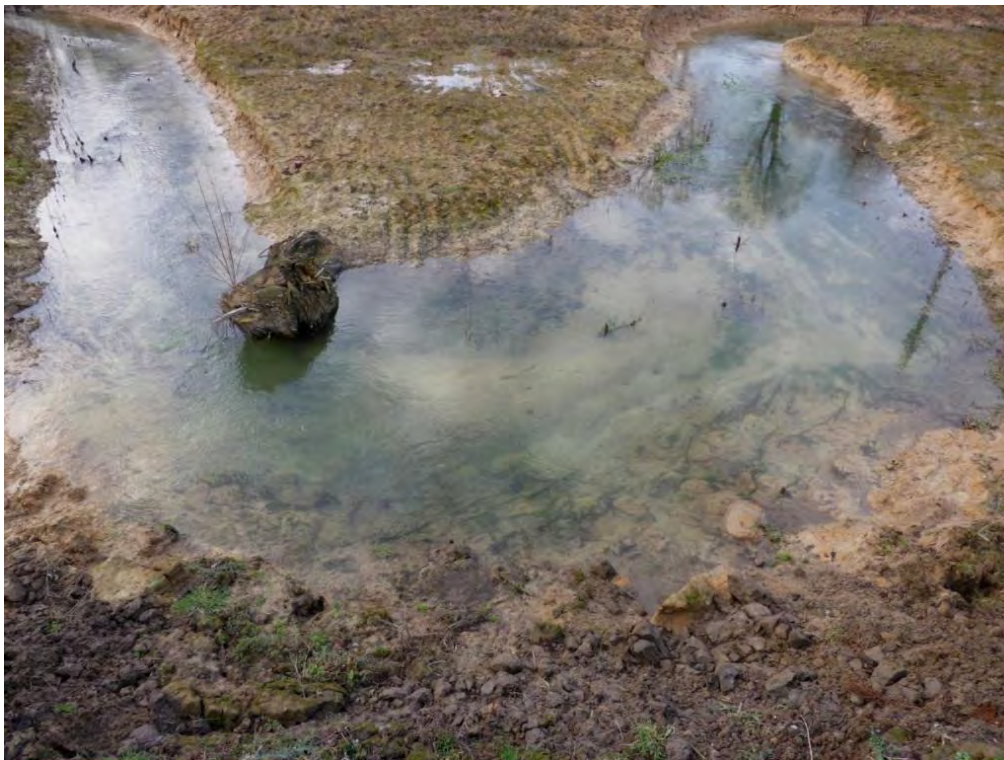
Abb. 36: Trotz Hochwasser und spärlichem Bewuchs reichen die Schleppkräfte nicht aus, um die nachbrechenden Lehmkluten vom Prallufer fortzuspülen (17. Januar 2015).
