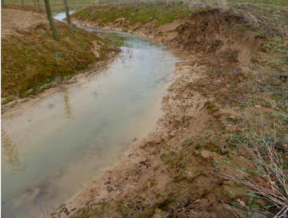
Abb. 31: Am Südufer sacken die Ufer in unterschiedlicher Intensität (16. Januar 2015).
