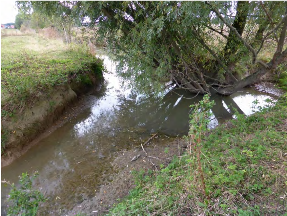
Abb. 28: Durch die Ausleitung auf das höhere Sohlniveau der Renaturierungsstrecke, im Bild vorne links, ist das ursprüngliche Sohlniveau um ca. einen Meter überstaut worden. Die Silber-Weide hat den Anstau ohne sichtbare Beeinträchtigung überstanden (16. September 2016).
