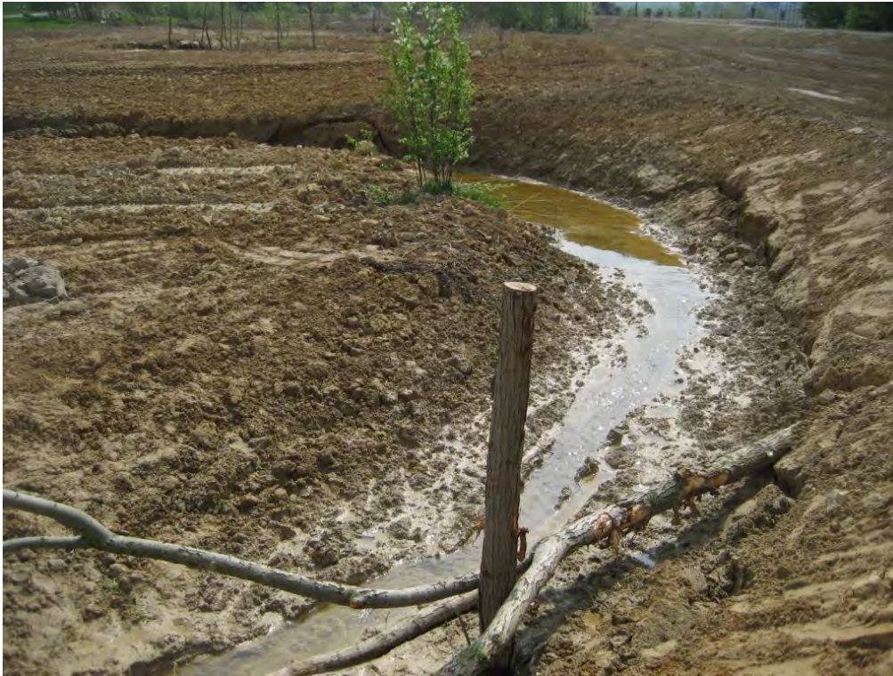
Abb. 60: Fertig gestelltes Trotzbachprofil östlich des Sportplatzes mit abgeböschten Ufern (25. April 2014).
