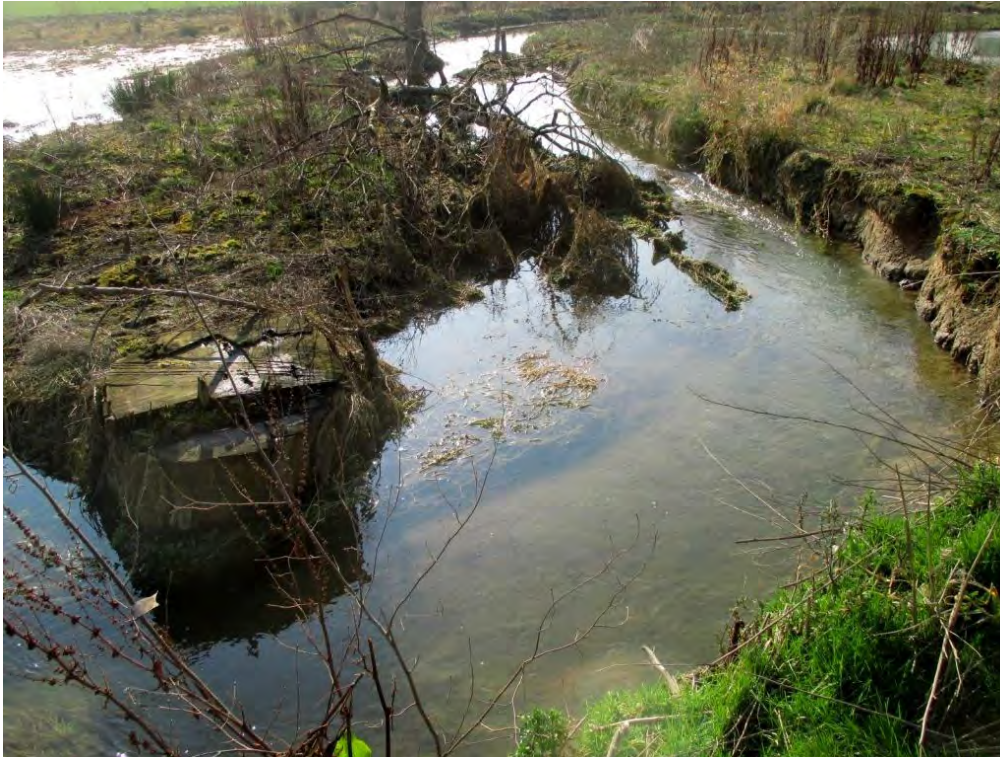
Abb. 54: Hochwasser hat das Bachprofil frei gespült (29. Februar 2016).
