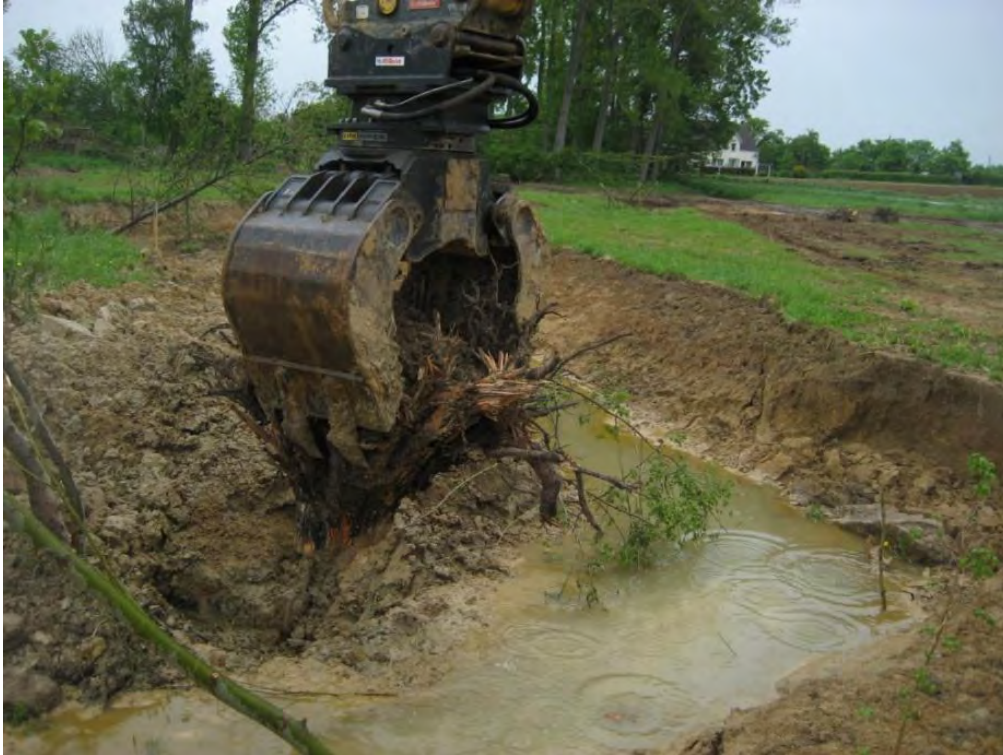
Abb. 7: Zur strukturellen Anreicherung werden Wurzelstumpen in das Profil gedrückt (07. Mai 2014).
