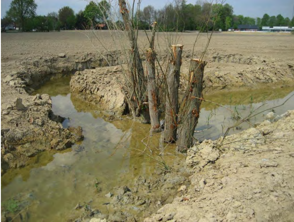
Abb. 48: Mit einem Sperrriegel aus Weiden-Setzstangen soll der Stromstrich in eine nachträglich gebaute Laufverlängerung gelenkt werden (25. April 2014).
