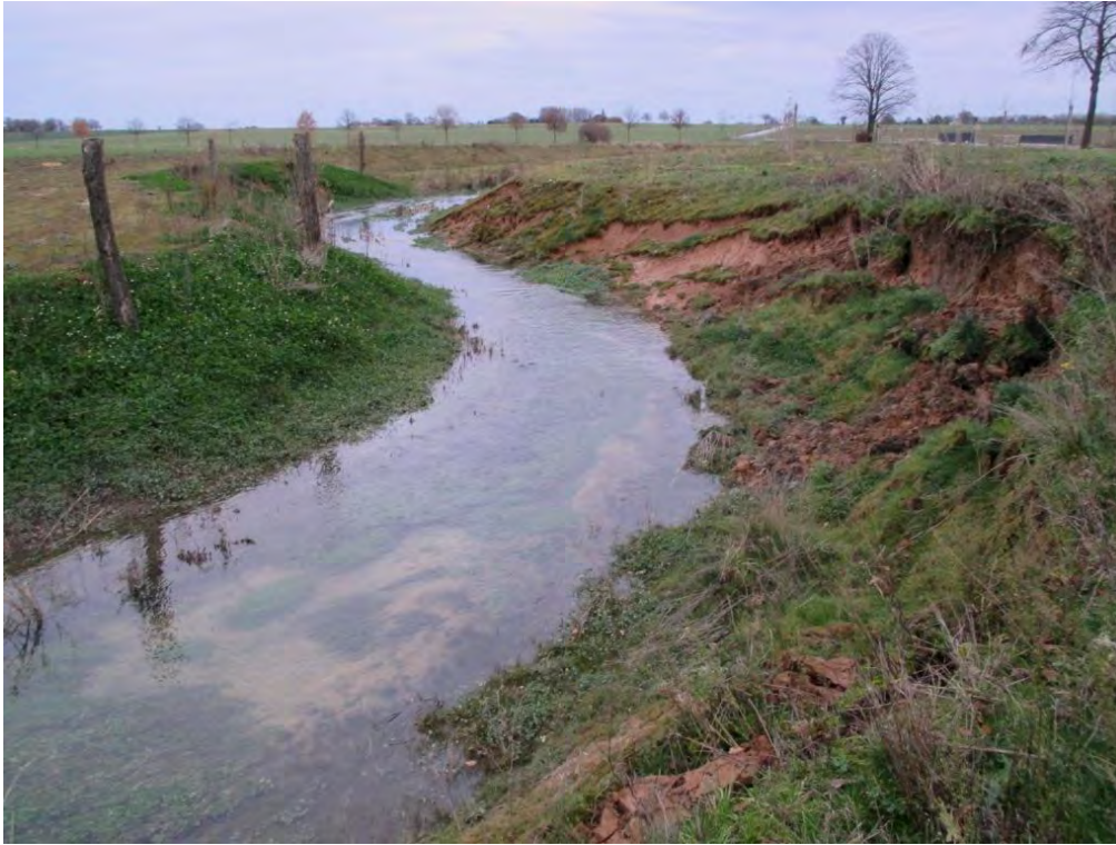
Abb. 33: Auch zwei Jahre nach Fertigstellung halten die Bodensackungen an. Besonders nach starken Regenfällen treten immer wieder Rutschungen auf. Am Nordufer ist ein dichter Teppich aus Weiß-Klee entstanden (05. Januar 2016).
