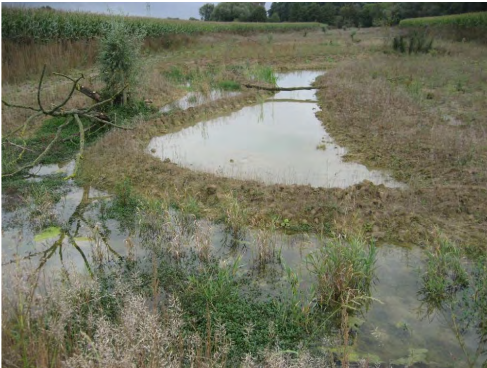
Abb. 57: Nach einer Vegetationsperiode sind die Pflanzen gut angewachsen. Das Tothzelement ist teilweise zusammengebrochen. Zur Sicherung gegen Verdriften ist es mit zwei Setzstangen aus Silber-Weiden befestigt worden, die nun ausgeschlagen sind (21. September 2014).
