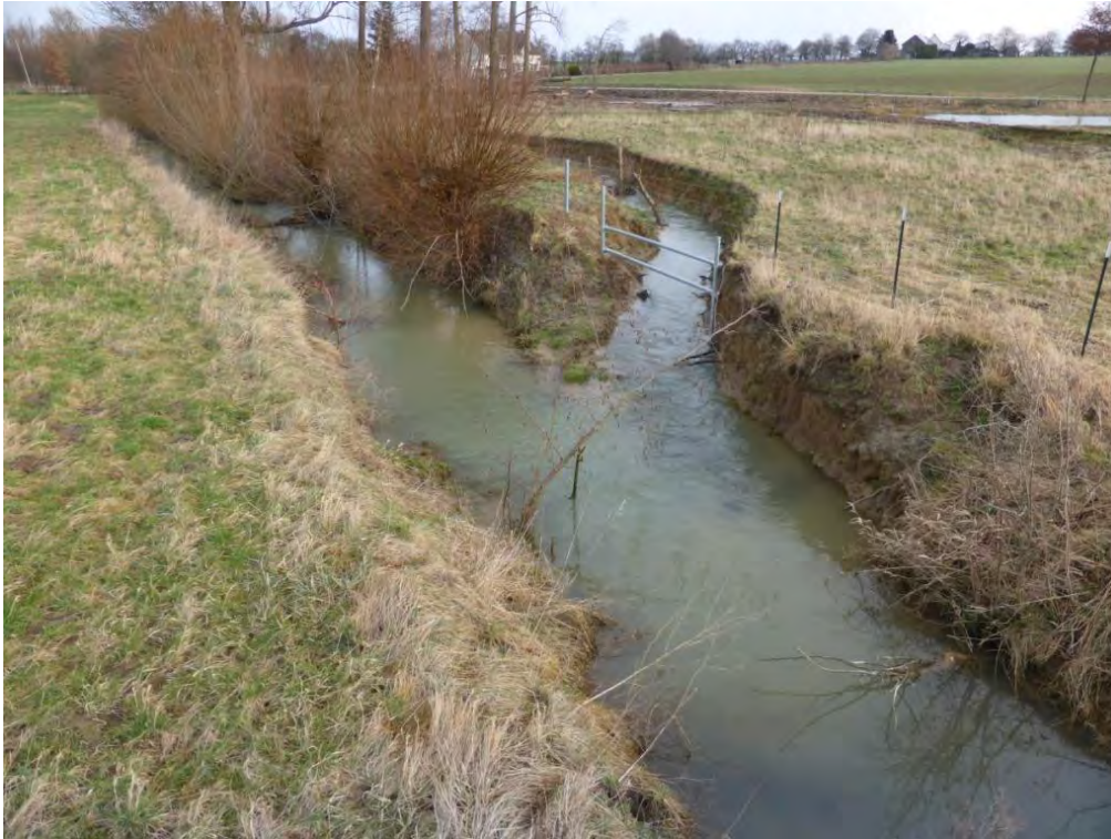
Abb. 6: Nur im Übergangsbereich zu dem alten, tief eingeschnittenen Profil blieben die neuen Steilufer standfest (18. Januar 2015).
