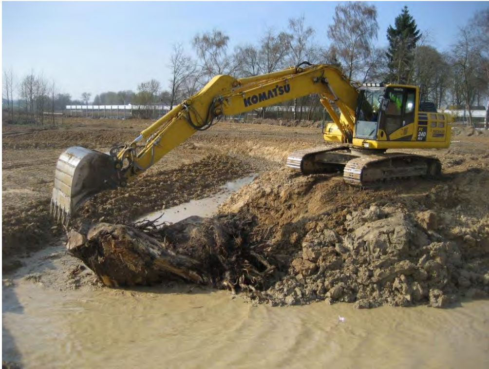
Abb. 35: Um den Stromstich zu bündeln und gegen das Prallufer zu lenken, wurden Weidenstumpen eingebaut. Dadurch sollte nachbrechender Boden vor der Steilwand weggespült und der Krümmungskolk von Feinsedimenten frei gehalten werden (25. April 2014).
