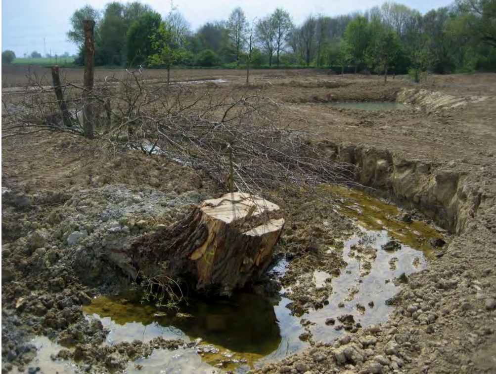
Abb. 52: Unmittelbar nach Fertigstellung sind die einzigen Strukturbildner im Profil die eingebauten Tot- und Lebendholzelemente (07. Mai 2014).
