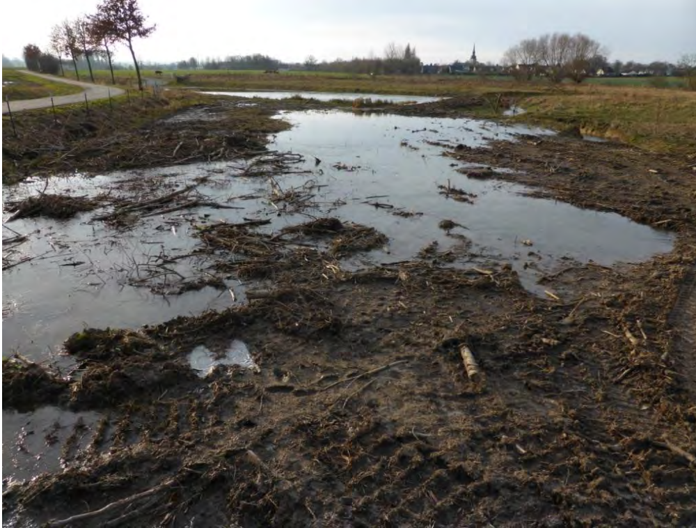
Abb. 15: Durch die großen Einschnittstiefen tritt Grundwasser in die Rinne zur Hochwasserentlastung aus. Mit diesem Wasser wird ein Teil der Aue am Pappelwald vernässt (18. Januar 2015).
