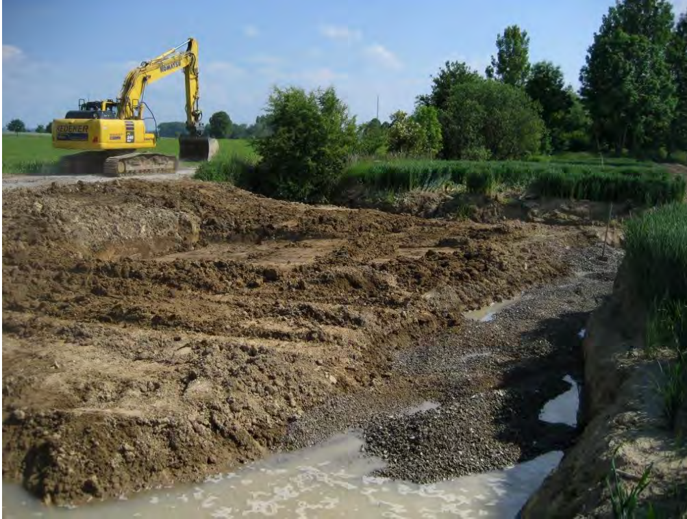
Abb. 24: Zur Optimierung als Forellenlaichstrecke wurden in einigen Abschnitten Probestrecken aus ungesiebttem Lippkies angelegt (02. Juni 2014).
