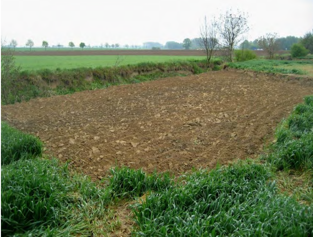
Abb. 18: Im Bereich der Laufverlängerungen wurde zunächst der gesamte Oberboden abgetragen. Noch verläuft der Trotzbach begradigt und tief eingeschnitten am oberen Bildrand (25. April 2014).
