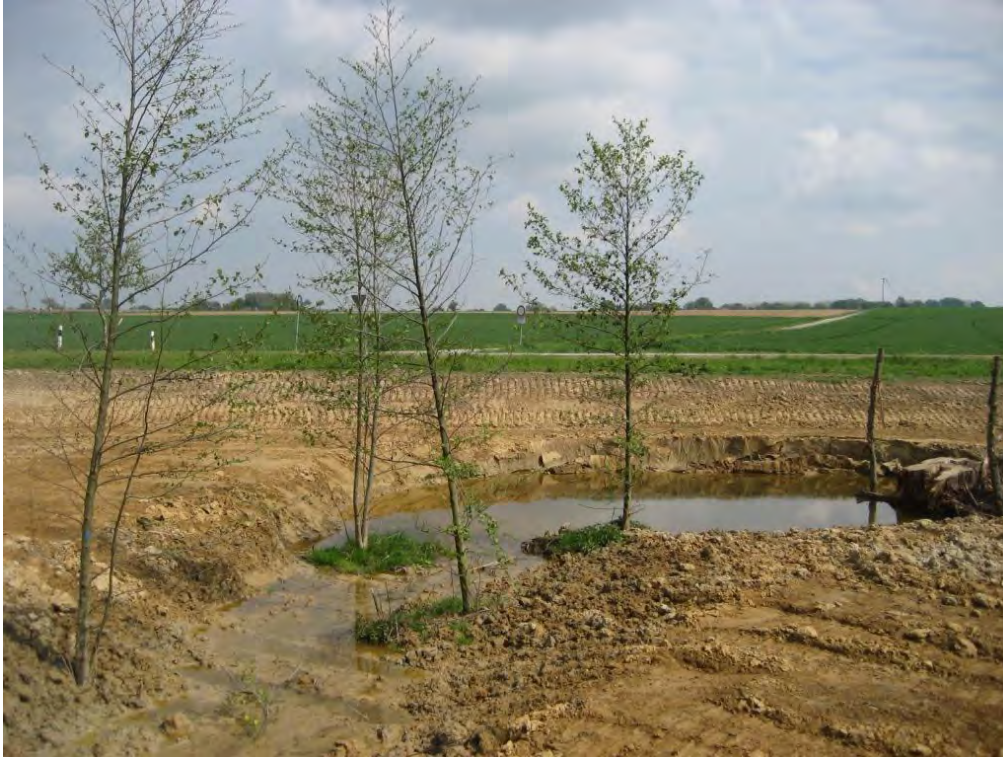
Abb. 70: Große, an den neuen Bachlauf verpflanzte Erlen mildern den Rohbaueindruck des neuen Bachlaufes (25. Mai 2014).
