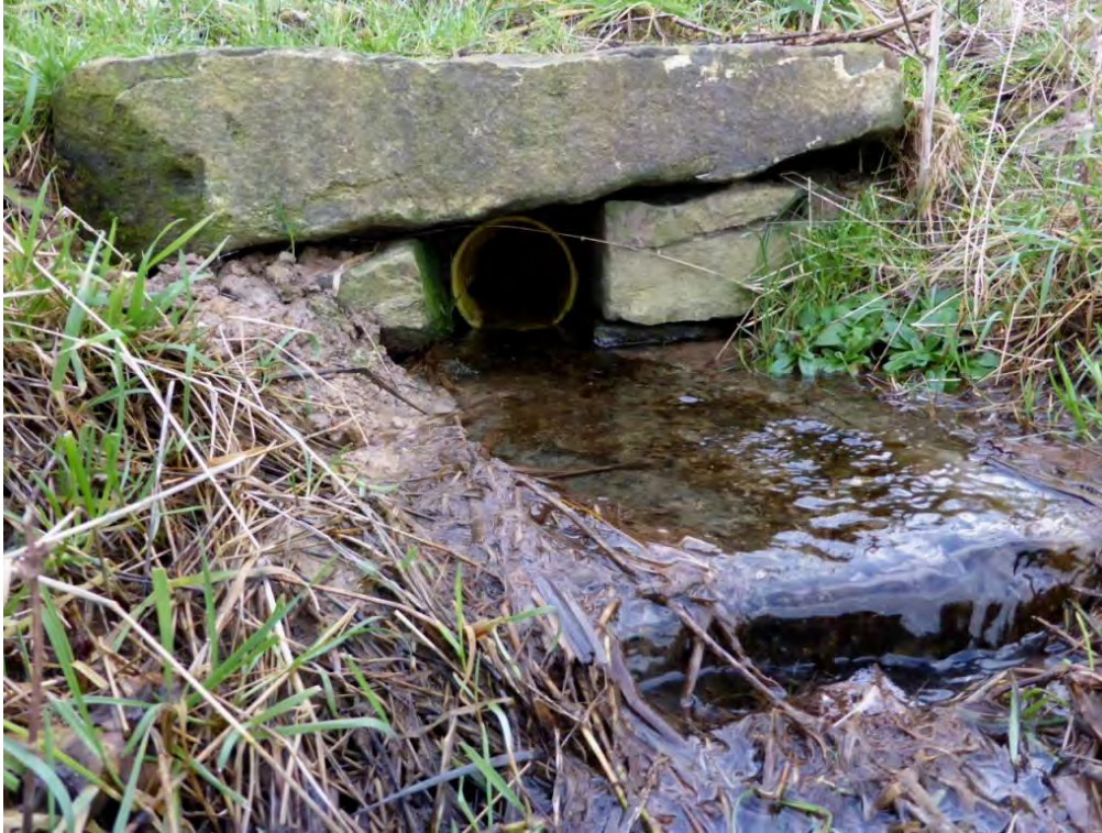
Abb. 79: Neue Auslaufbauwerke für Drainagesammler: Die untere Steinplatte hält den Auslauf frei von Bewuchs, die obere schützt vor Beschädigung durch Überfahren (17. Januar 2015).
