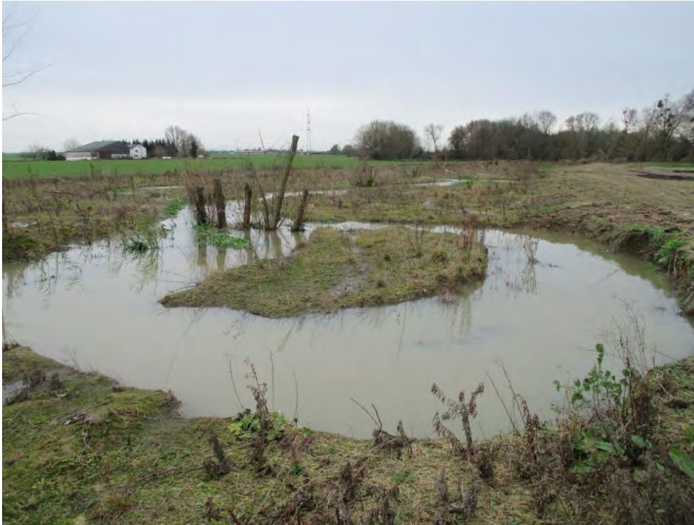
Abb. 50: Bei Hochwasser wird die beabsichtigte Wirkung des Sperrriegels deutlich (01. Dezember 2015, Aufnahme gegen die Fließrichtung).
