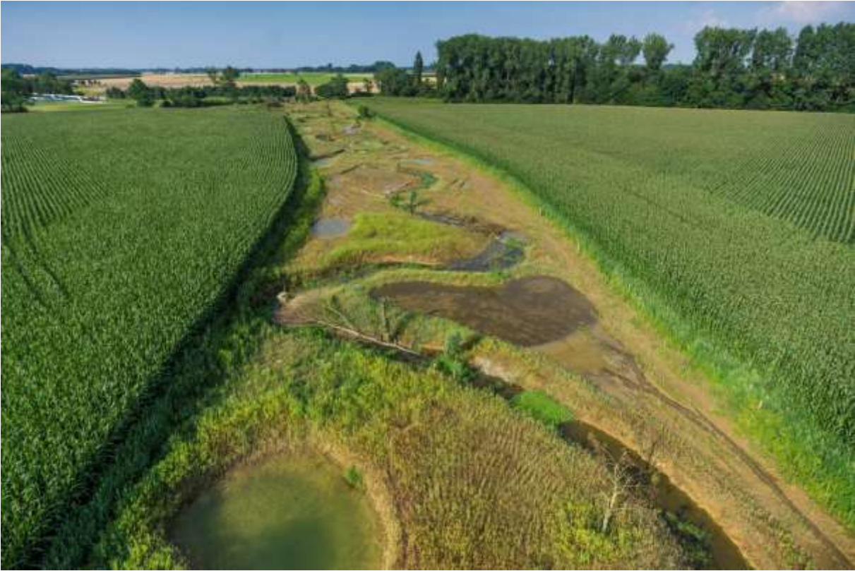
Durch Oberbodenabtrag wurde eine Ersatzauze geschaffen, in der das neue Gerinne verläuft.
