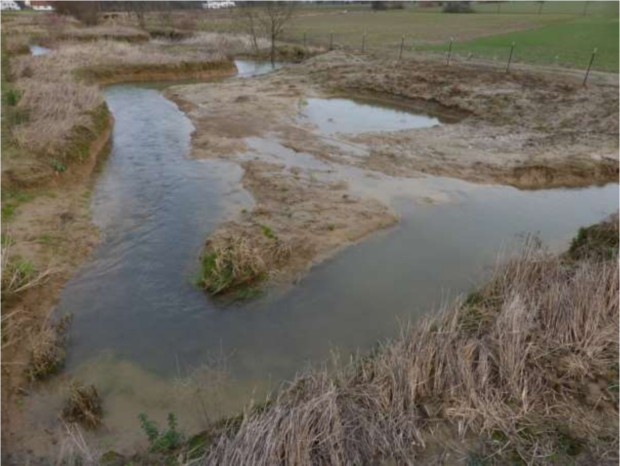
Geringe Einschnittstiefen führen zu häufigen Ausuferungen in die (Ersatz-)aue
