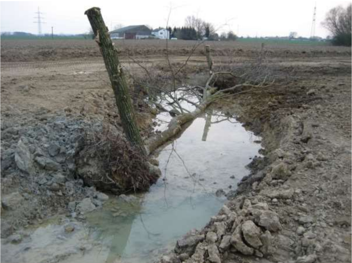
Sicherung von Totholz durch Setzstange am Wurzelteller
