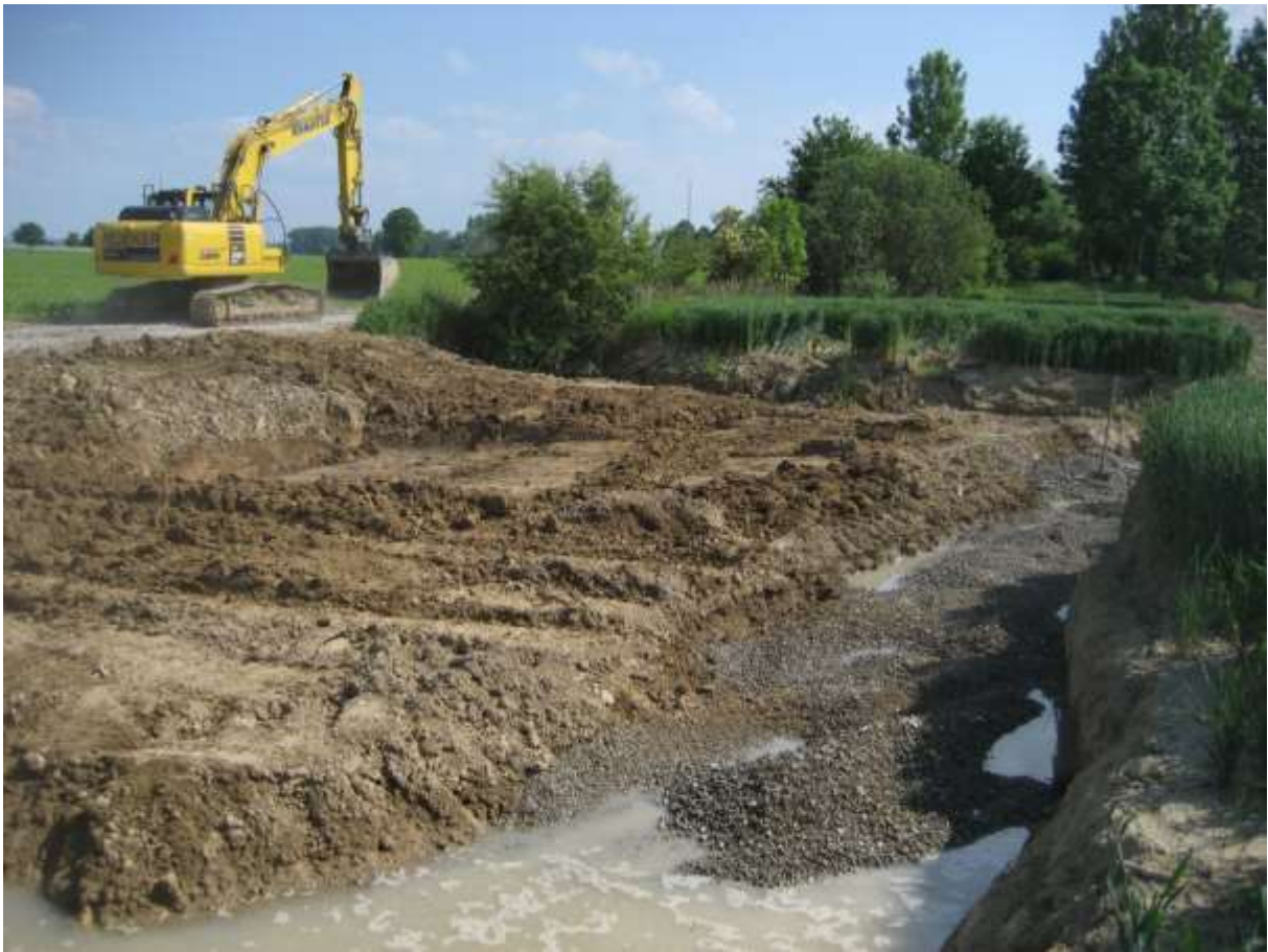
Bereichsweise wurde unsortierter lokaltypischer Kies als Laichstrecke eingebaut. Hierfür wurden Strecken mit höherer Fließgeschwindigkeit gewählt, um den Kies von Feinsedimenten freizuhalten.
