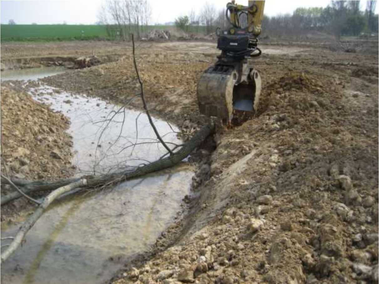
Sicherung von Lebendholz durch Eingraben der Stammbasis oder des Wurzeltellers in der Uferböschung
