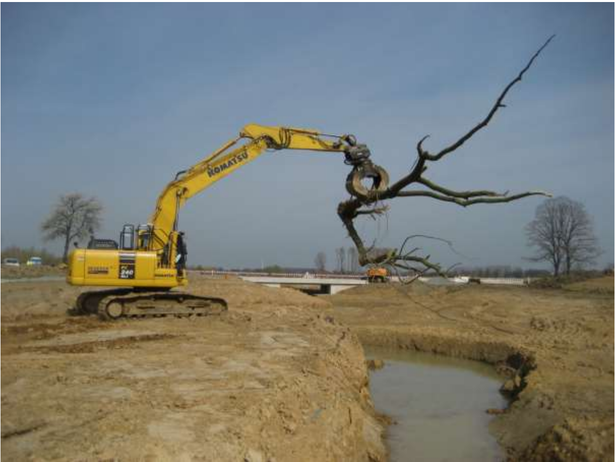
Einbau eines Silber-Weidenstammes als Lebendholz
