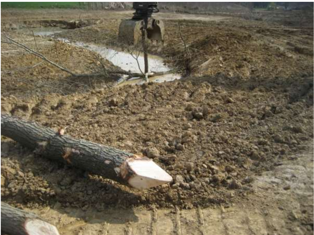
Ausschlagfähige Setzstangen von Baumweiden, Länge 3-5 m, Zopfmaß Ø 15-25 cm, mit der Kettensäge angespitzt, wurden als Verankerung für Tot- und Lebendholz gesetzt
