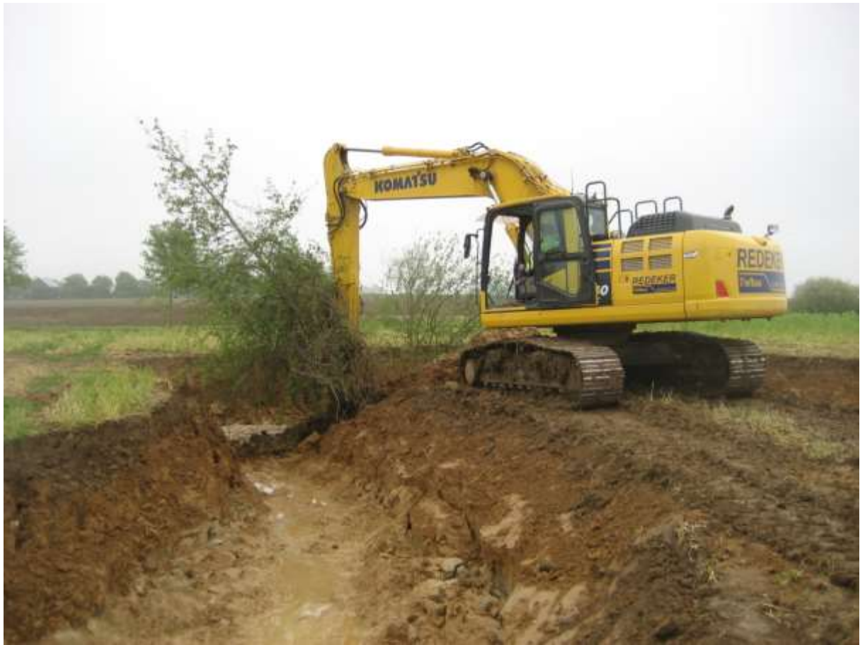
Vor der Verfüllung des ehemaligen Verlaufs wurden die Ufergehölze entnommen, in vorbereitete Pflanzlöcher am neuen Gerinne gesetzt und gewässert
