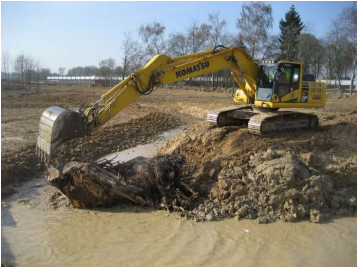
Einbau von Baumstubben zur Strömunglenkung und Kehrwasserbildung
