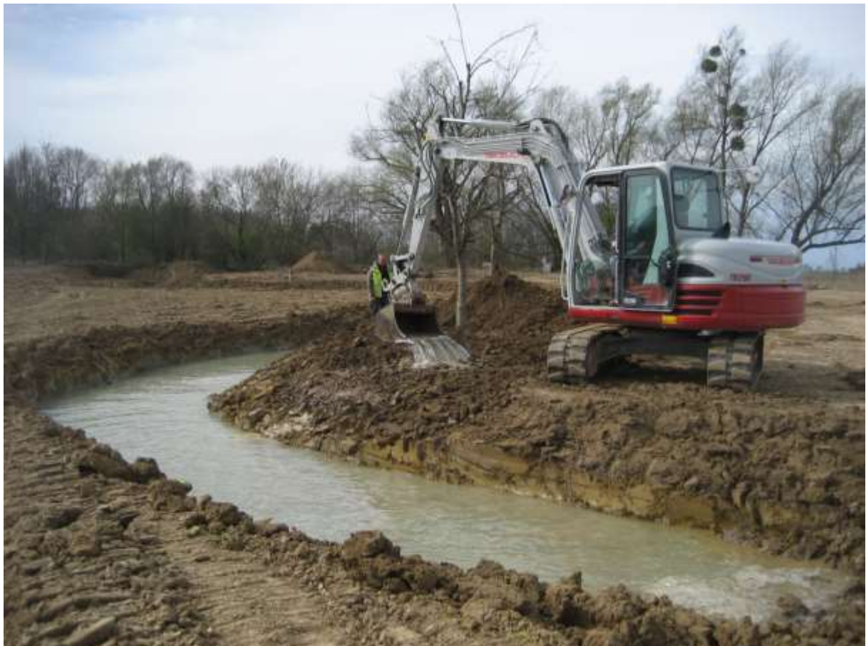
Vor der Verfüllung des ehemaligen Verlaufs wurden die Ufergehölze entnommen, in vorbereitete Pflanzlöcher am neuen Gerinne gesetzt und gewässert
