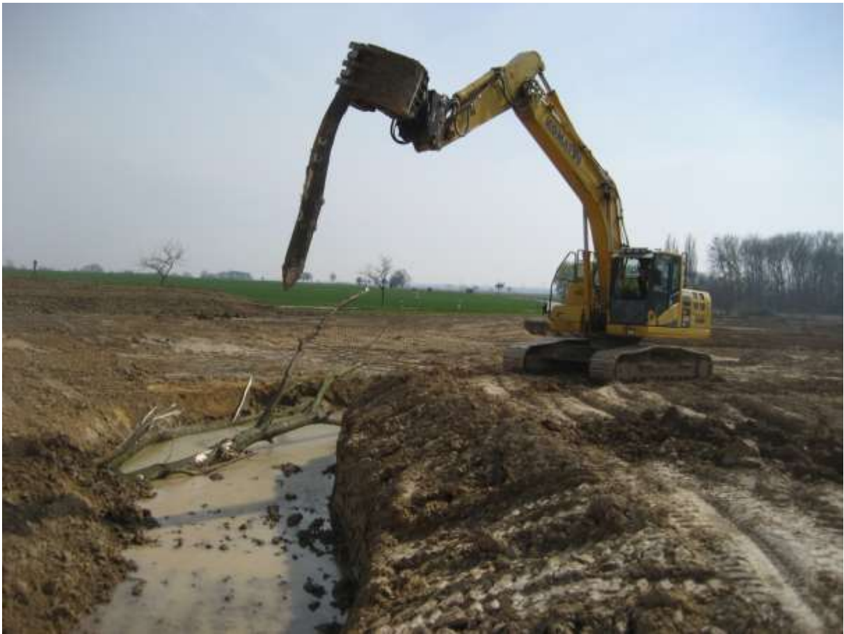
Ausschlagfähige Setzstangen von Baumweiden, Länge 3-5 m, Zopfmaß Ø 15-25 cm, mit der Kettensäge angespitzt, wurden als Verankerung für Tot- und Lebendholz gesetzt
