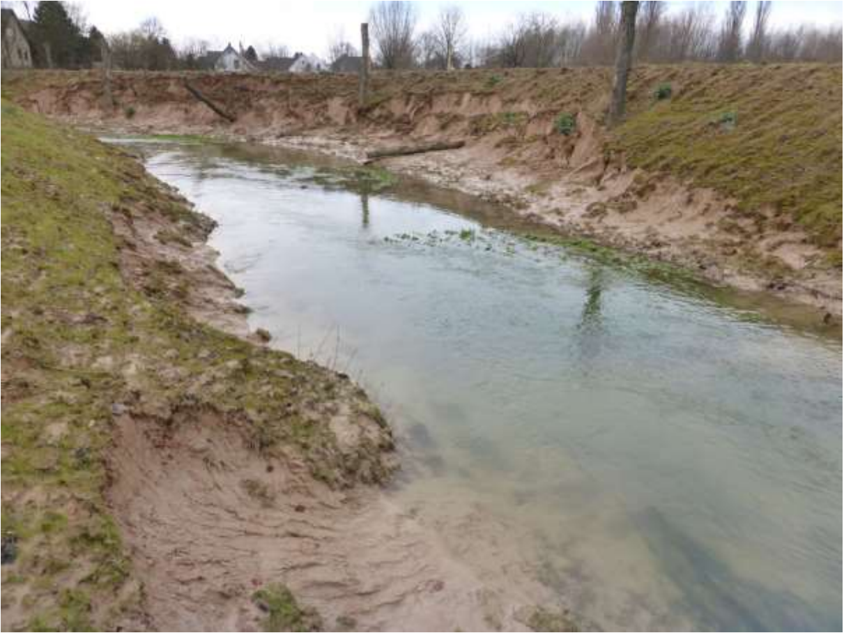
In den tiefen Profilen ‚floß‘ der feine, plastische Boden der unteren Schichten in den Bach
