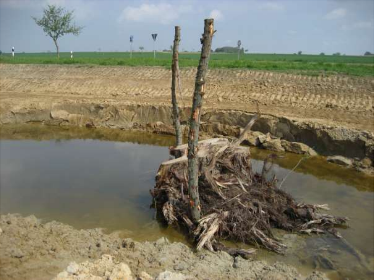
Stubbensicherung mit Setzstangen von Baumweiden
