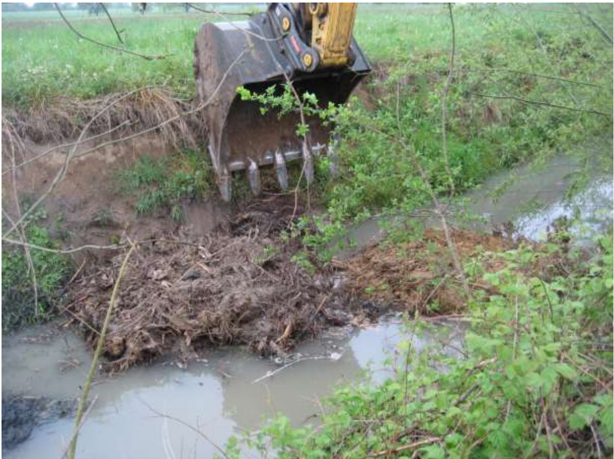
Einbau von Baumstubben zur Strukturanreicherung im Bestandsverlauf
