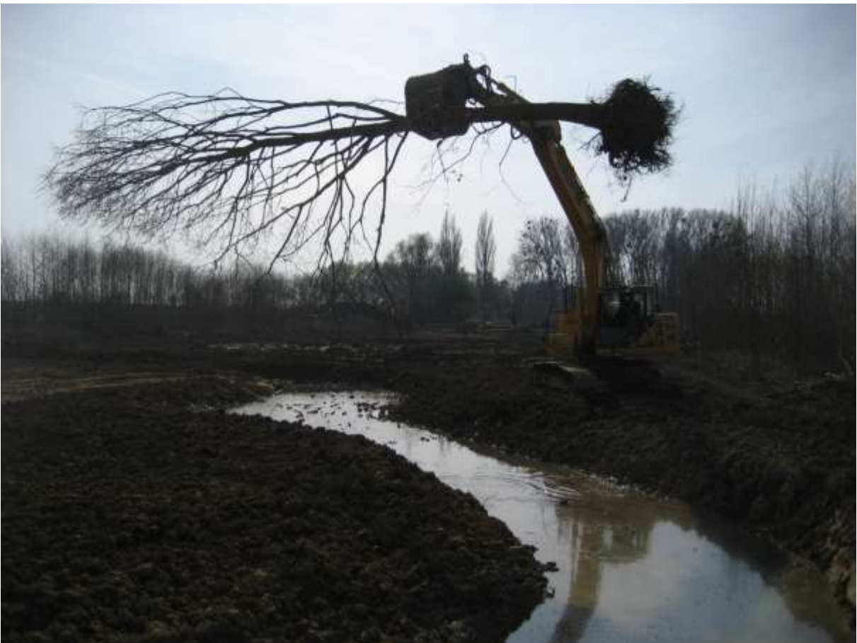
Einbau einer Eiche samt Wurzelballen als Totholz
