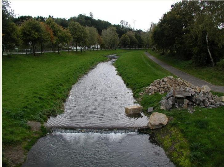
2004 wurden 20 Sohlabstürze aus Beton, Baustahl und z.T. alten Strommasten abgebrochen und durch Sohlgleiten ersetzt. Dadurch wurde die ökologische Durchgängigkeit für alle Fließgewässerorganismen wieder hergestellt.
