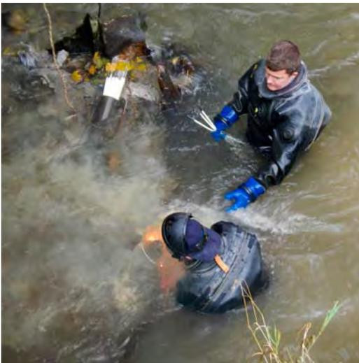
Nicht nur Erdbauarbeiten waren zu erledigen. Oberhalb des Diebeswegs musste in der Sohle der Lippe eine Stahlspundwand unter Wasser abgebrannt werden.
