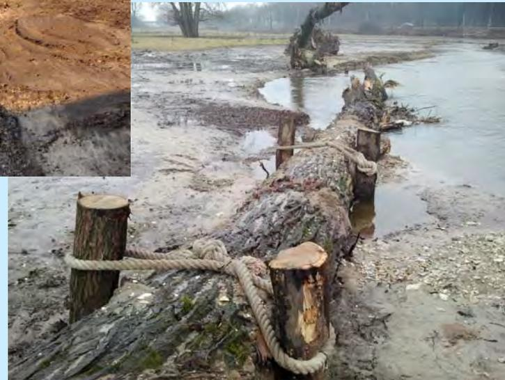
Lediglich im Abzweig- und Einmündungsbereich an der alten Lippe mussten einzelne größere Pappeln gefällt werden. Diese wurden zur Strukturanreicherung als Totholz an dem neuen Flussabschnitt eingebaut. Totholz hat eine ganz besondere Bedeutung für die Entwicklung naturnaher Flüsse und Bäche.
