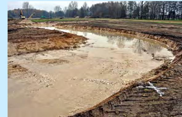
Insgesamt wurden auf ca. 6 ha Fläche der Oberboden abgeräumt und ca. 7.000 cbm Unterboden ausgehoben.
