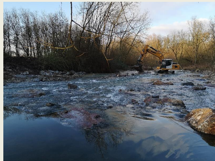
23.01.2020 Restarbeiten Raue Gleite
