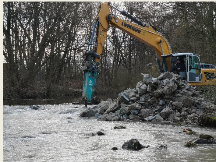
15.01.2020 Abbruch Betonschwelle
