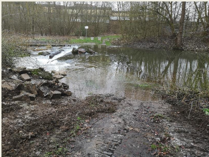
14.01.2020 Entfernung Natursteinbelag der Furt
