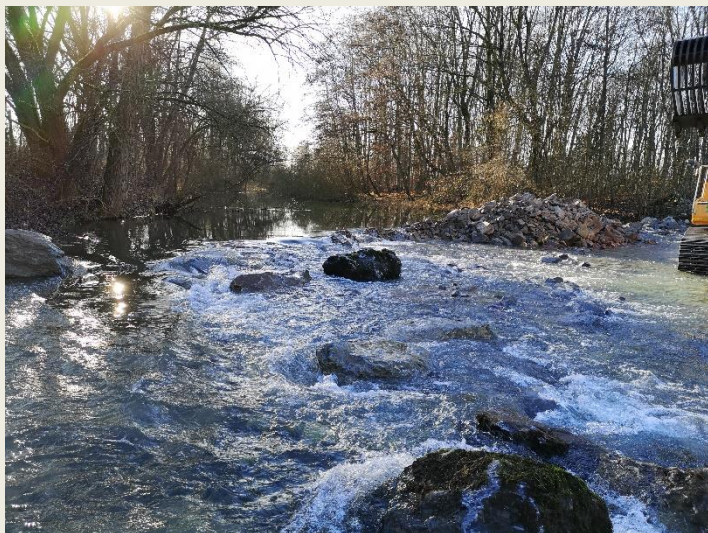
21.01.2020 Einbau Gleite und Störsteine
