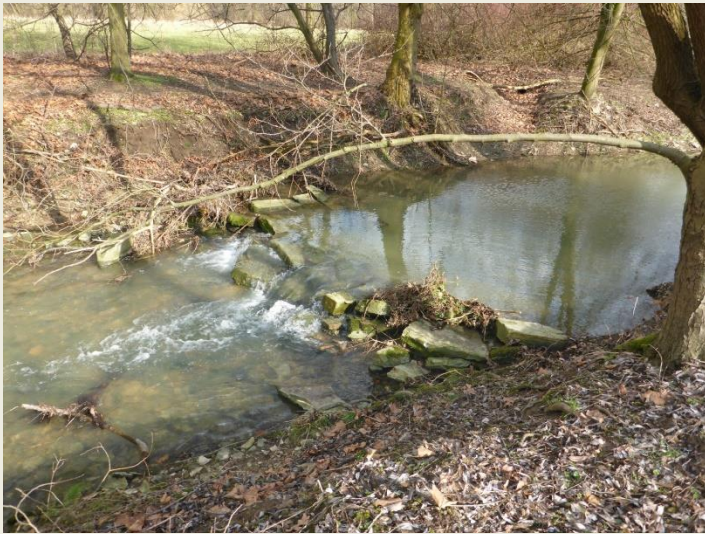
01.03.2017 Sohlschwelle aus Uferbefestigung
