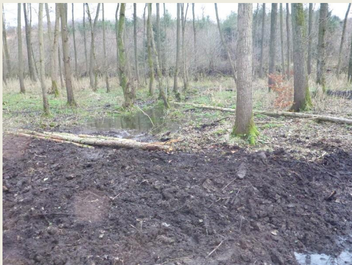
07.12.2017 Abdämmung der Quelldrainagen zur Wiedervernässung der Fläche
