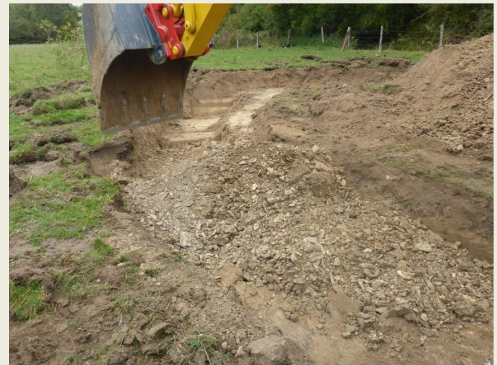
04.10.2018 Einbringen von Kies in Gewässersohle
