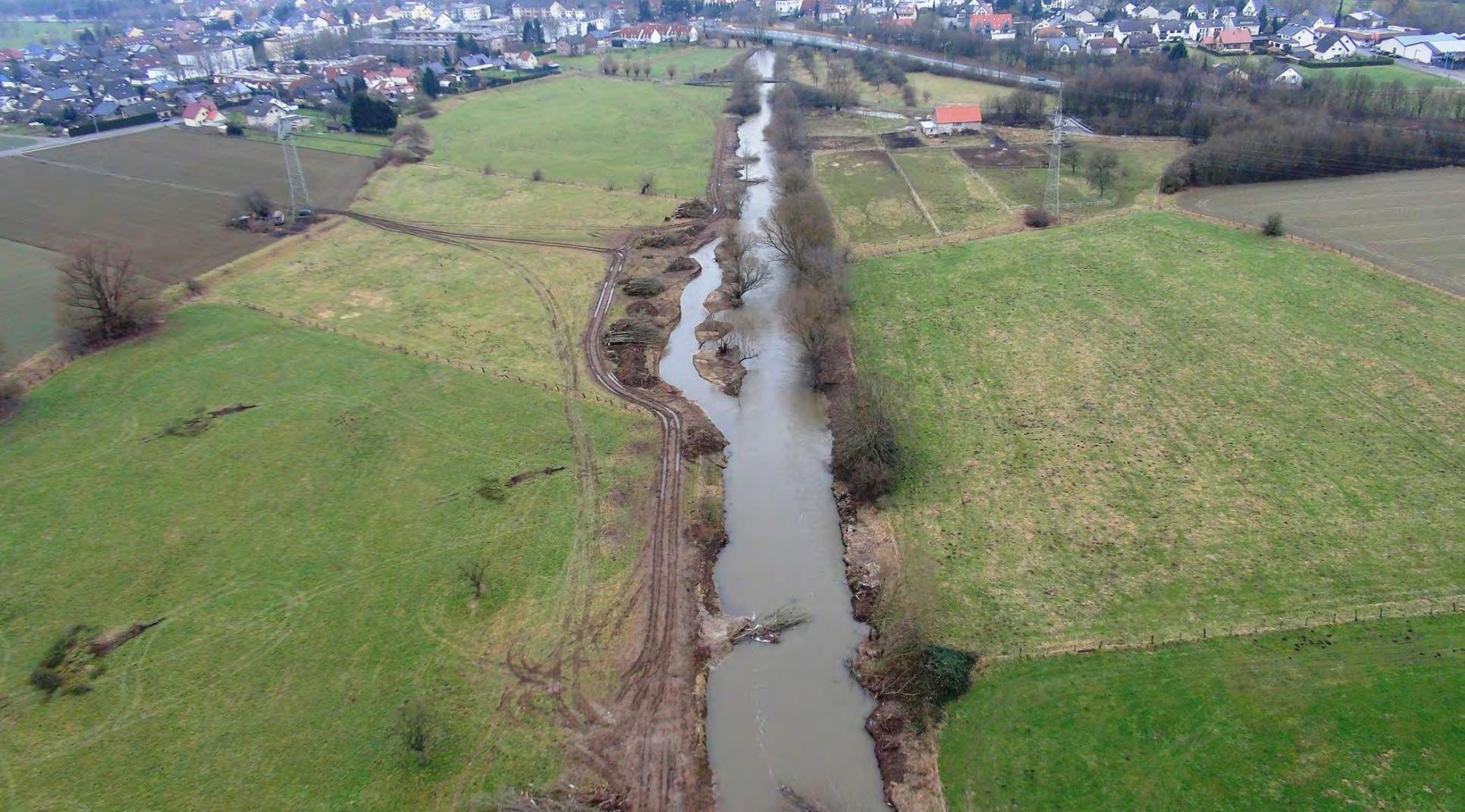
Januar 2015: Aufweitung, Entnahme Uferverbau, Totholzeinbau
